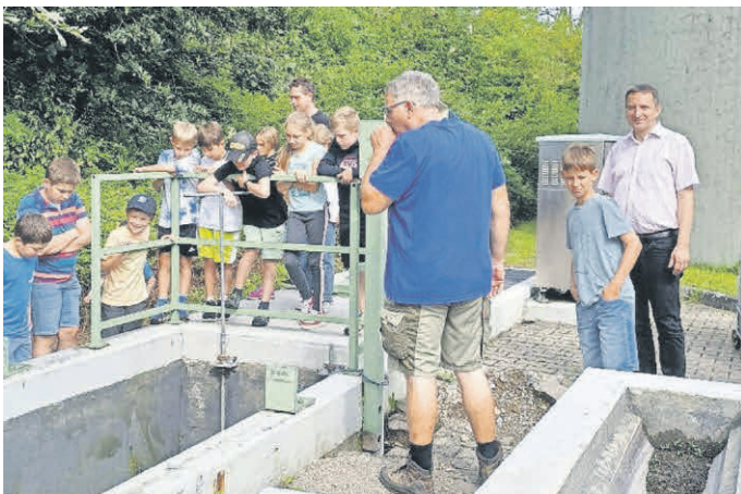
Das Abwasser wird nach der Entfernung von grobem Schmutz in die Becken geleitet.
